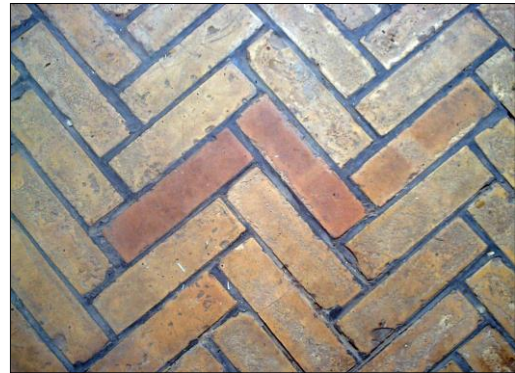
شكل (٣) أرضية من الطابوق الفرشي- بيت السويدي
