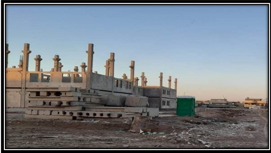
صورة لابنية غير مكتملة البناء لمشروع محطة ماء حصن جعفر ٢٠٢٣.
